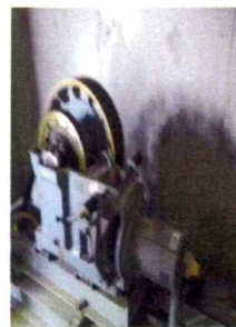
Mal estado de los equipos de elevadores
