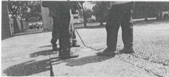
Figura 7. Tapa de registro eléctrico del CAST.
