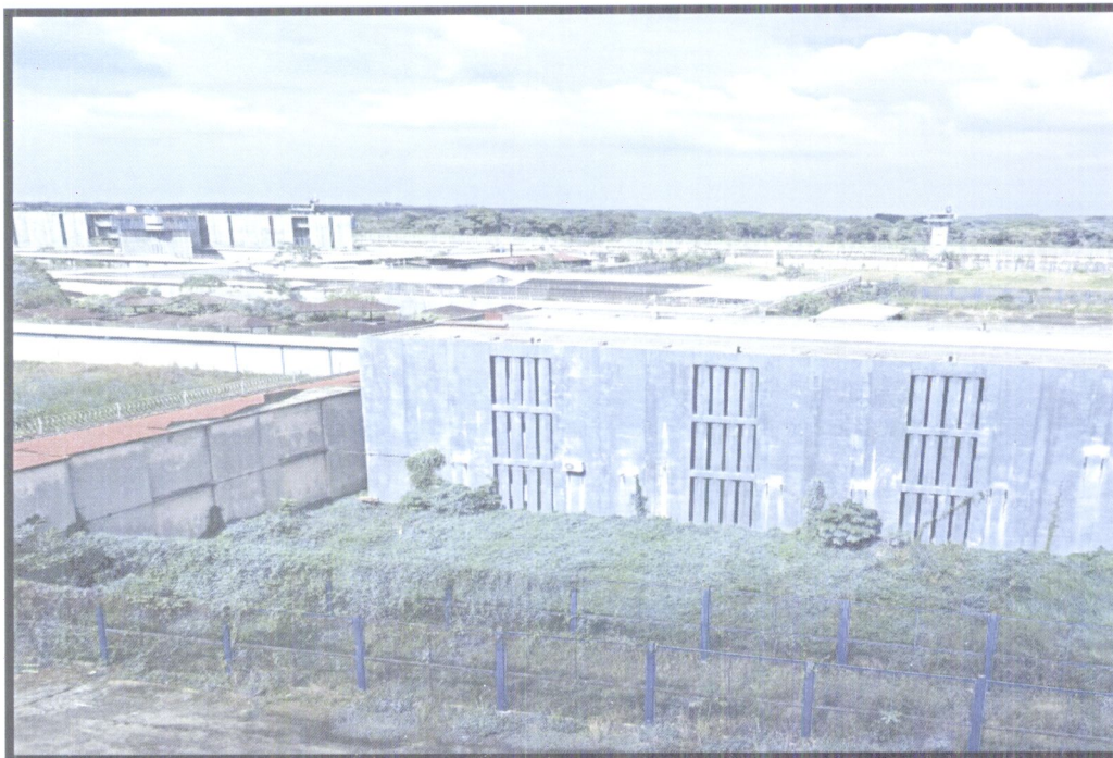
Imagen 2. Inmueble del desincorporado Centro Federal de Readaptación Social No. 6 (CEFERESO 6)
