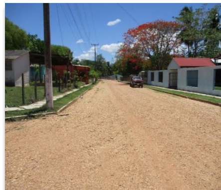
OPH-002.- Rehabilitación de calles de terracería con material pétreo de 1 1/2" a finos.
