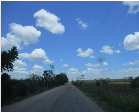
14110218.- Rehabilitación de terracerías, obras complementarias y pav. Asfáltico del camino villa el Triunfo- Pedregal del km. 4+500 al 28+000.
