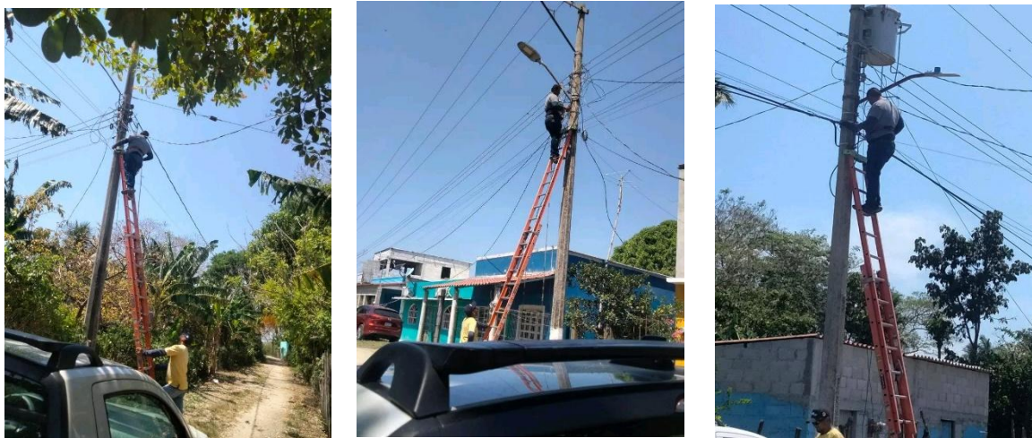
Ilustración 3 VIZUALIZACION DE REPARACION DE LA ENERGIA ELECTRICA INCONCLUSA (8 DE JULIO DEL 2025)
