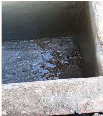
Foto Desviación de fuga de agua potable a registros sanitarios.
