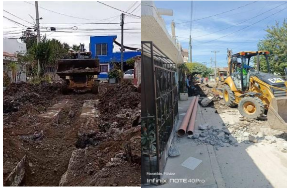
Foto inicio de corte de pavimento.
