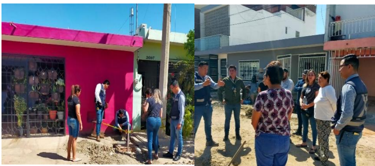
Foto Reunión en obra con Contraloría social, obras públicas y contratista para indicar detalles y revisando de registros sanitarios.
