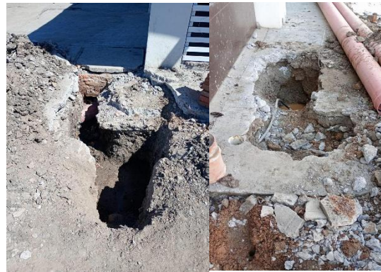
Foto Reubicando mangueras y tubo de cobre.
