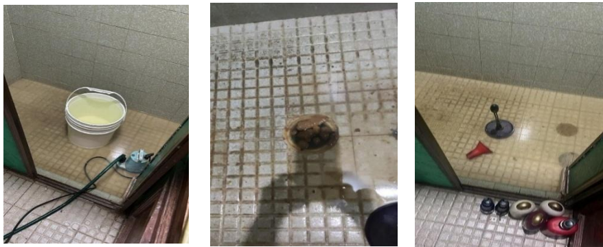
Fotos Drenaje rebosando dentro de las casas.
