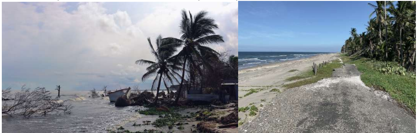
Figura 9. Efectos de los frentes fríos en la pérdida de línea de costa en El Bosque, Centla (izquierda) y corte de vías colindantes con la costa de los municipios de Cárdenas y Paraíso debido al impacto de la marea de tormenta (derecha).
