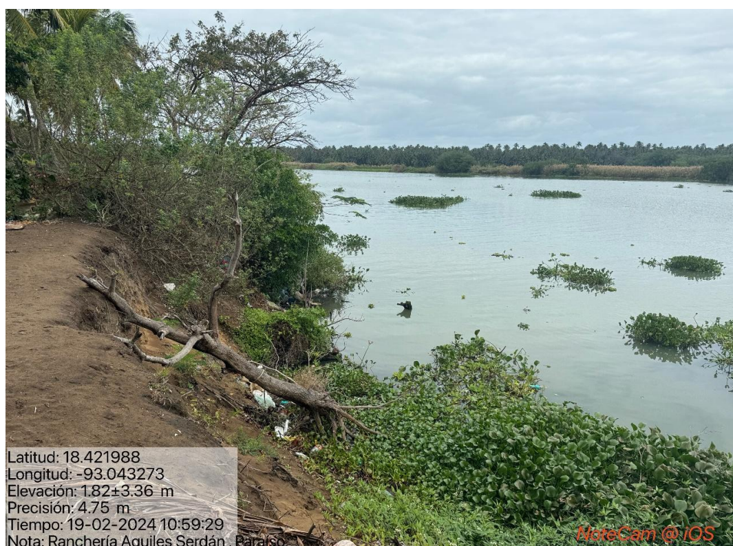
Figura 30. Erosión de los márgenes de ríos cuando aumenta el volumen de agua que transportan en épocas lluviosas e inundaciones. Ranchería Aquiles Serdán, Municipio de Paraíso. Fotografía de Ricardo Collado Torres.
