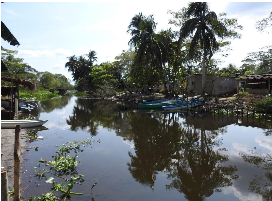
Figura 34. Casas que en época lluviosa se inundan ante la crecida de los cuerpos de agua. Municipio de Jalapa.
