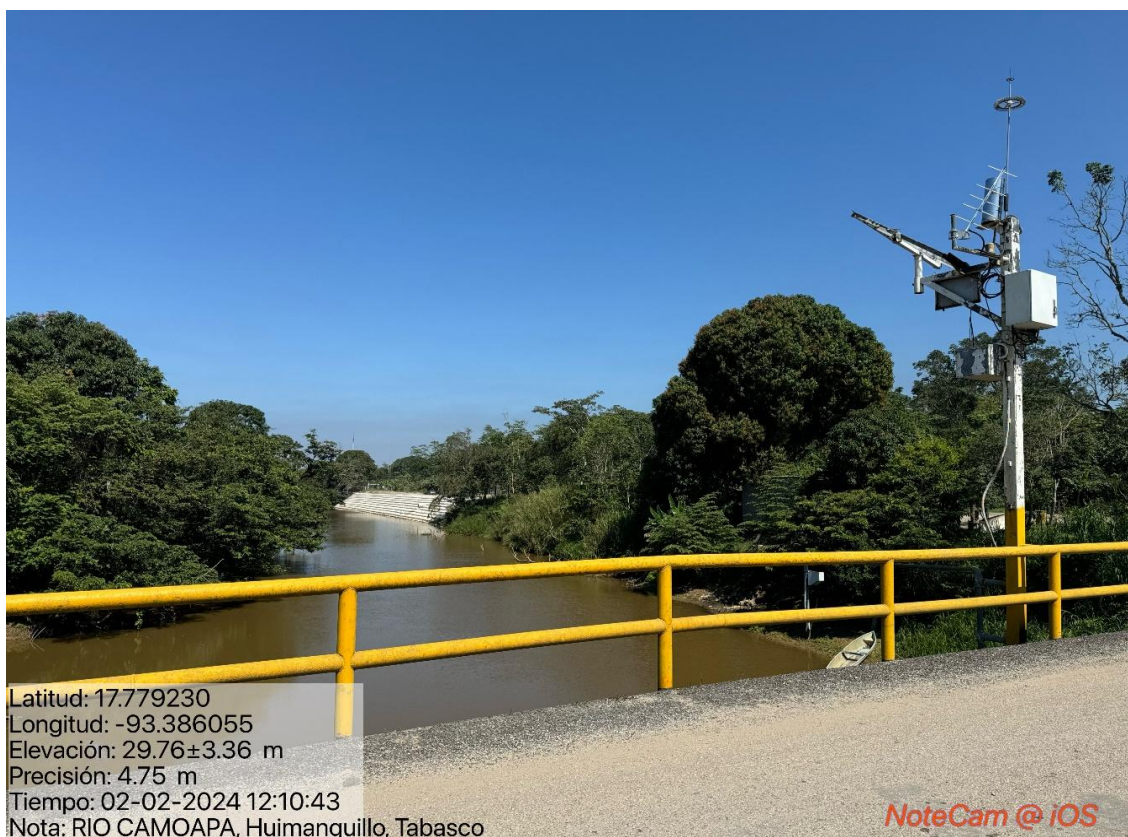
Figura 30. Instrumental instalado para monitorear el flujo y nivel del río Camoapa, en Huimanguillo. Al fondo se aprecia protección a base de concreto en la margen del río. Fotografía de Ricardo Collado Torres.
