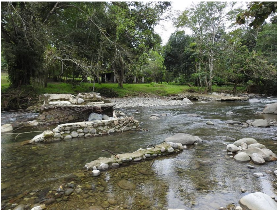
Figura 32. Los ríos y arroyos en época de lluvias arrastran gran cantidad de piedras que destruyen construcciones a su paso y orillas de su cauce. Municipio de Teapa. Fotografía de Ricardo Collado Torres.
