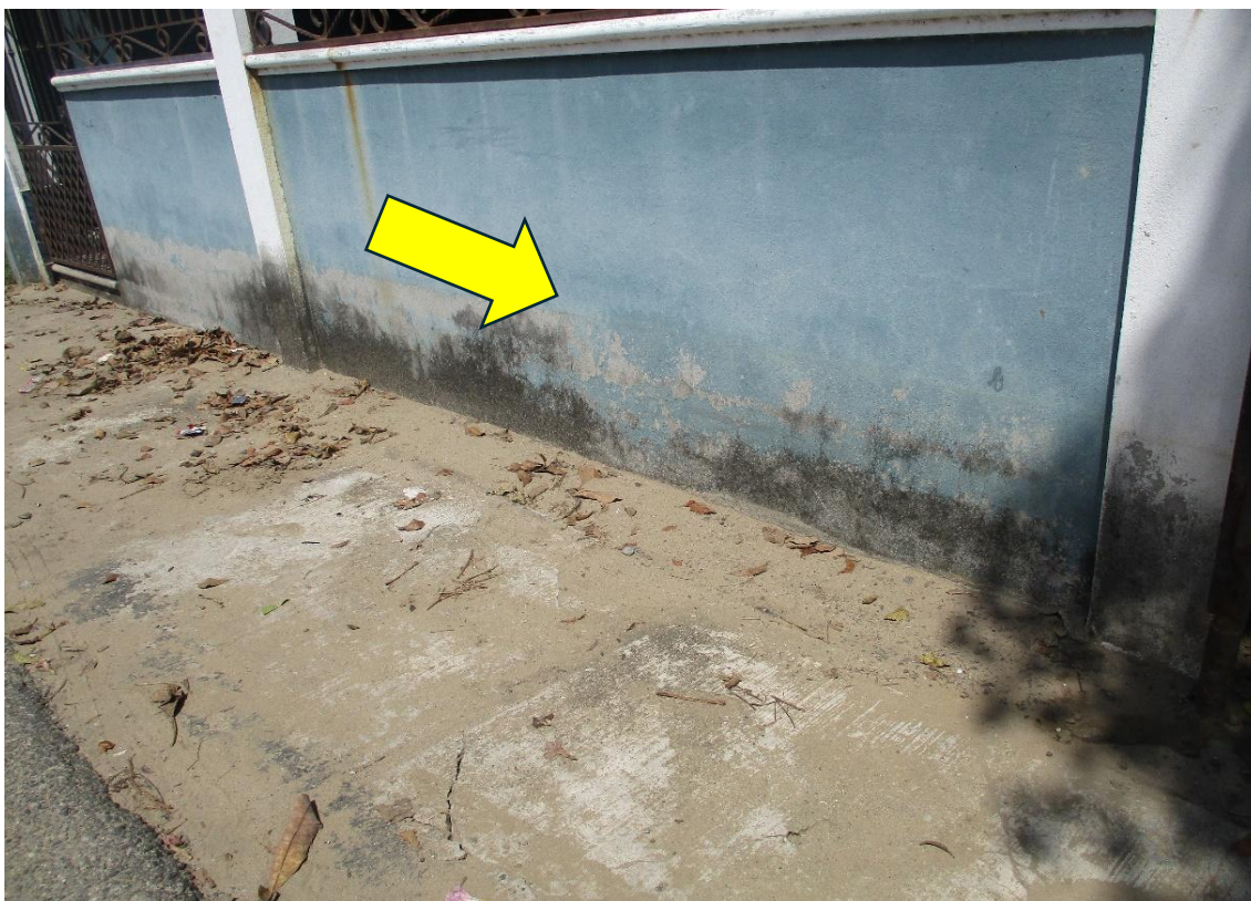
Figura 32. Altura que alcanza la inundación en zonas habitadas de Centla. Fotografía de Ricardo Collado Torres.
