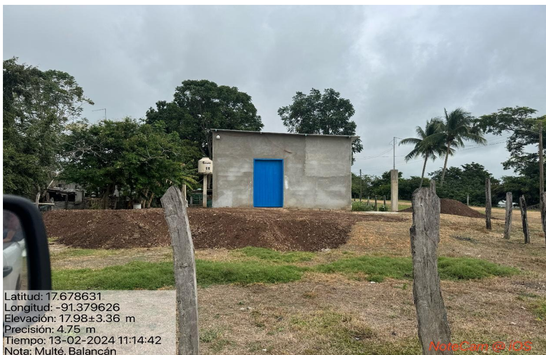
Figura 34. Esfuerzo de los pobladores rurales por minimizar los daños por inundaciones a sus viviendas, elevando el terraplén sobre la cual construyen. Poblado Multé, Balancán. Fotografía de Ricardo Collado Torres.
