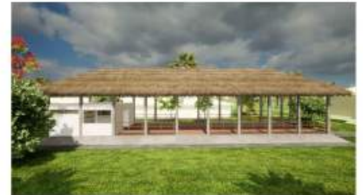
Propuesta de reacondicionamiento con techo de guano
