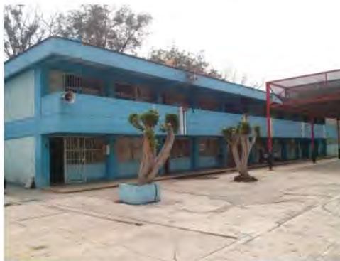
Imagen 17.- Se observa estructura tipo U2C.
