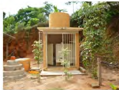
Imagen 1.- Talud sin protección en el plantel.
