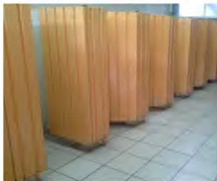
Imagen 15.- Se observan mamparas metálicas.
