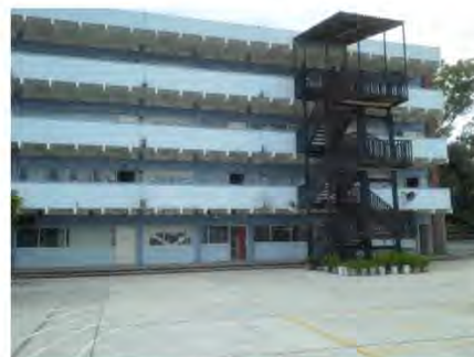
Imagen 20.-Fotografía de la escalera de emergencia.
