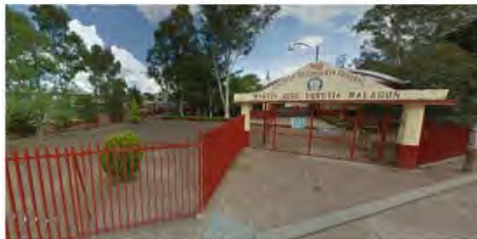
Imagen 21.-Fotografía del acceso principal y reja perimetral.
