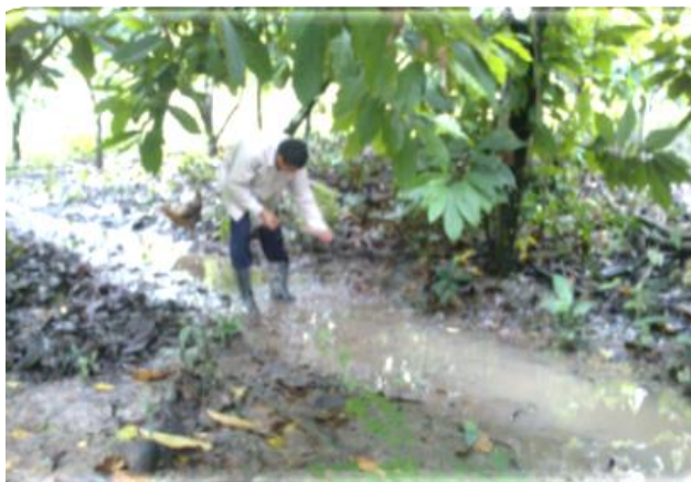
Desazolve manual de canal de riego
