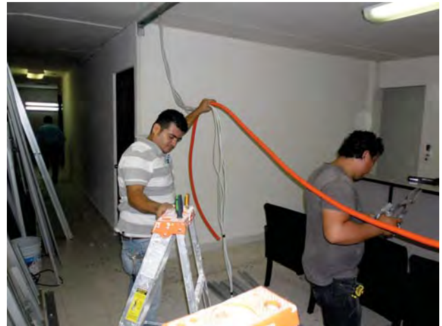
Mantenimiento en instalación eléctrica
