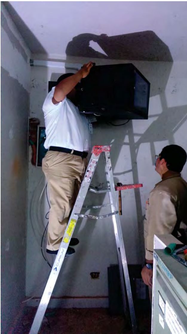
Instalación de equipos de redes
