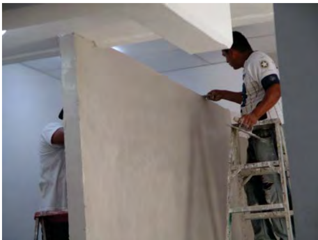
Rehabilitación de espacios para atención médica
