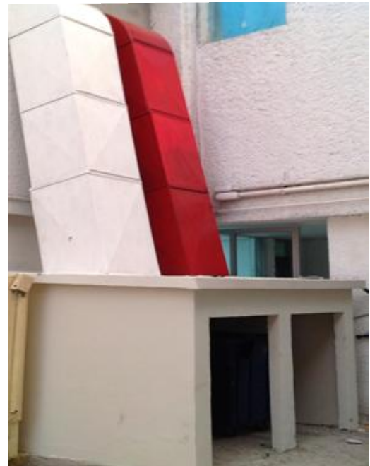
Construcción de toboganes de salida de residuos peligrosos biológico infecciosos y de ropa sucia en el CEMI
