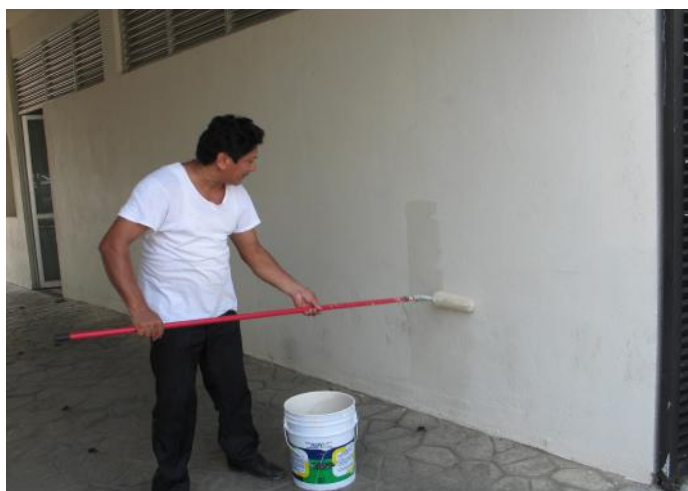
Aplicación de pintura a edificio de la Funeraria del ISSET
