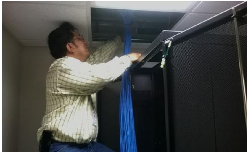
Instalación de 8 mil 845 metros de cableado de red en centros de trabajo del ISSET
