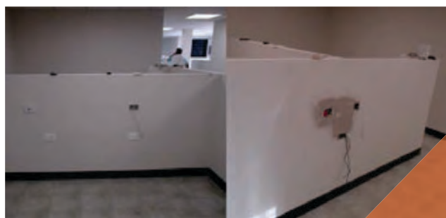
Instalación de nodos de red
