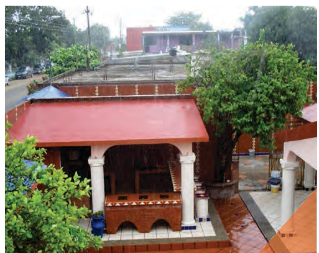
Mantenimiento general de la Unidad de Medicina Familiar de Balancán (después)
