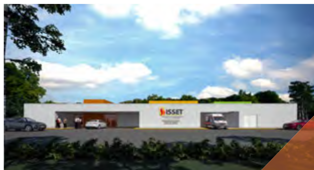
Proyecto de la Unidad Médica de Primero y Segundo Niveles de Atención Regional de Emiliano Zapata
