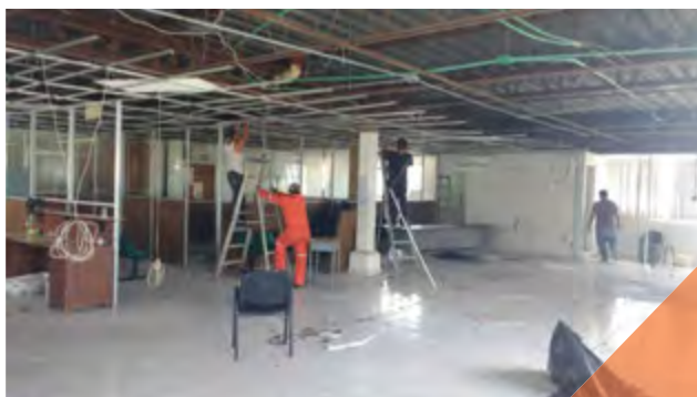
Remodelación del Centro de Especialidades Médicas del ISSET
