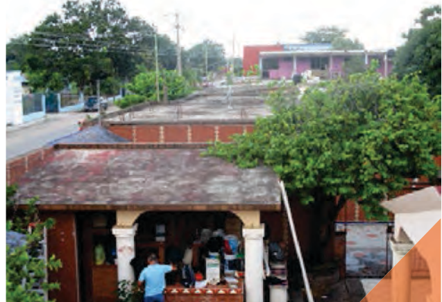
Mantenimiento general de la Unidad de Medicina Familiar de Balancán (antes)
