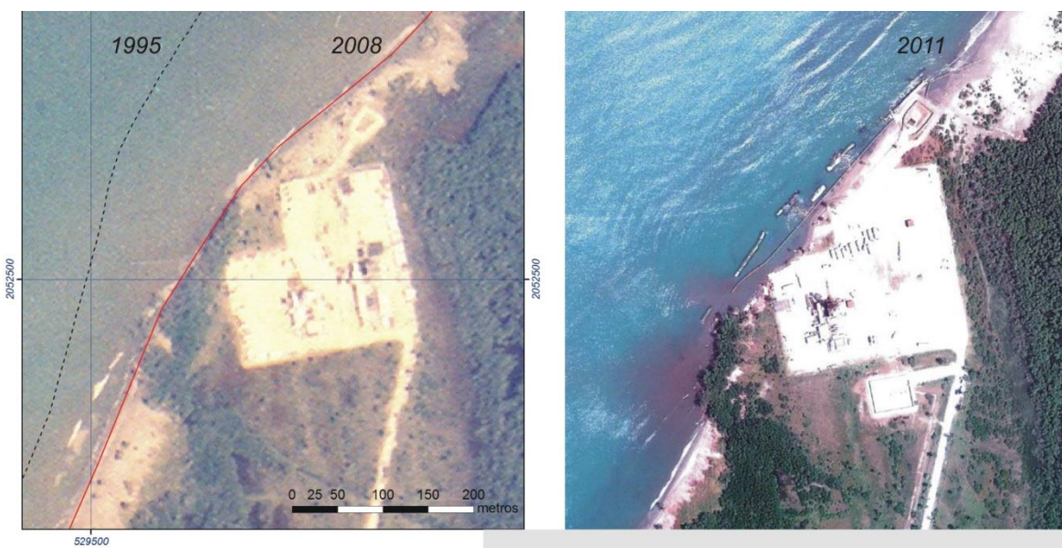
Figura 72. Imágenes de referencia comparativa de las instalaciones de PEMEX en pozos petroleros Tizón y Cráter, localizados inmediatamente al sur de la desembocadura del brazo distributivo occidental del delta del Grijalva. La imagen de la derecha es tomada de Google Earth, 2011.
